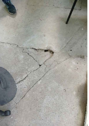
FOTO 06 REFAZER CONTRAPISO E COLOCAR PISO
