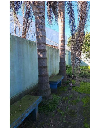
FOTO 10 PINTURA DOS MUROS E BANCOS
