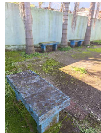
FOTO 11 PINTURA DOS MUROS E BANCOS
