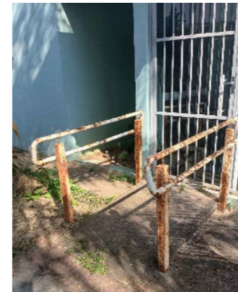
FOTO 08 RAMPA A SER DEMOLIDA E CORRIMÃO REMOVIDO
