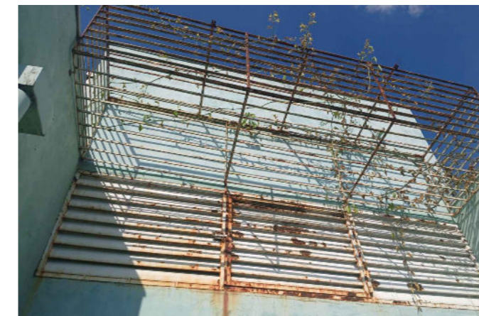
FOTO 12 REMOVER GRADE AR-CONDICIONADO E SUBSTITUIR ESQUADRIA
