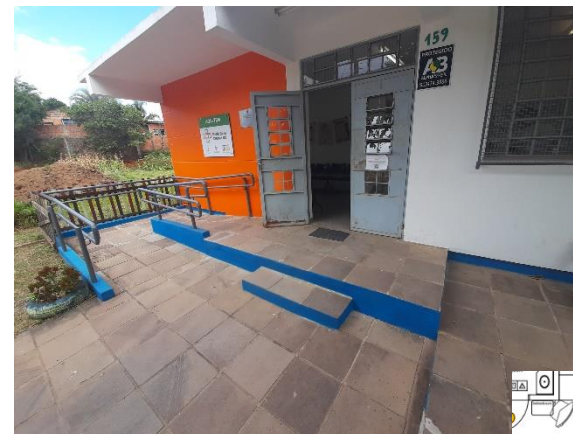
Rampa e degraus existentes
